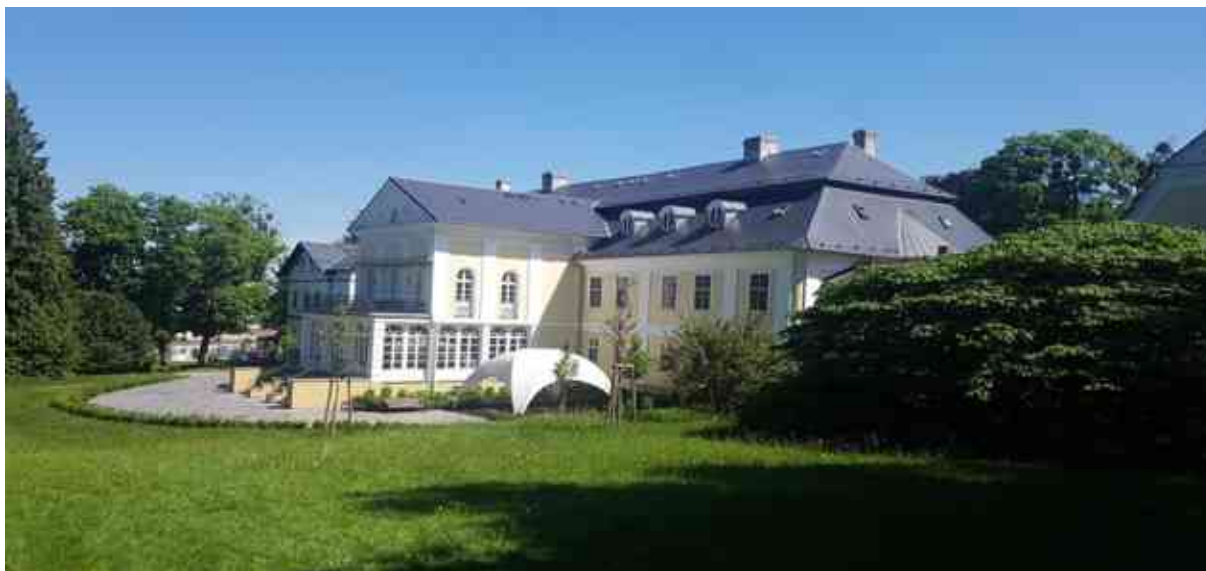
Hlavní budova čp. 1
